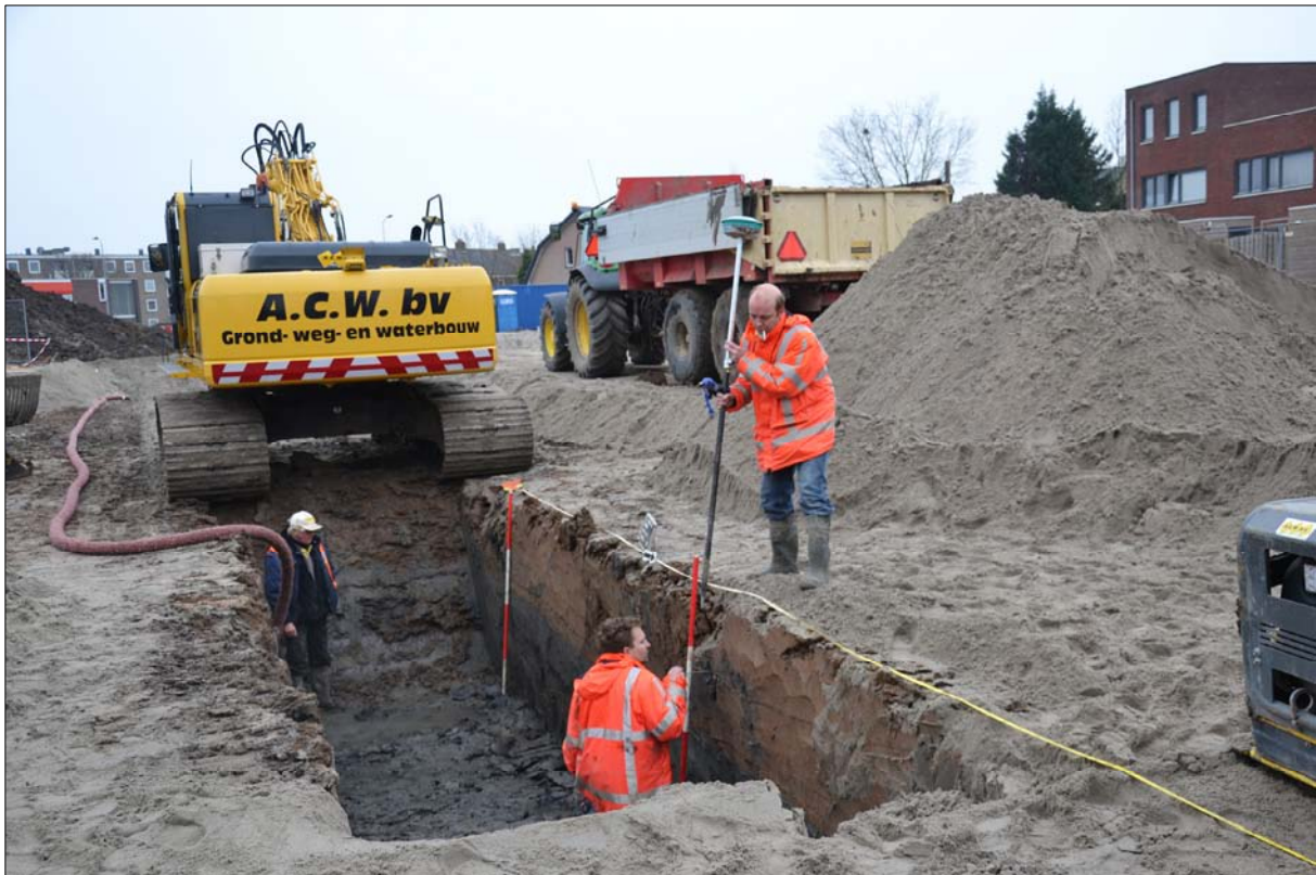
Fig. 4.2 Tiel - Vahstalterrein. Werkfoto tijdens de archeologische begeleiding van het uitgraven van het riooltracé (21/01/2014).
